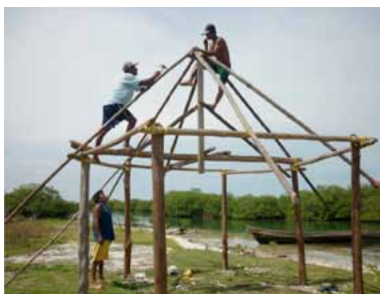
Construcción del nuevo centro de visitantes en Dainyaa
